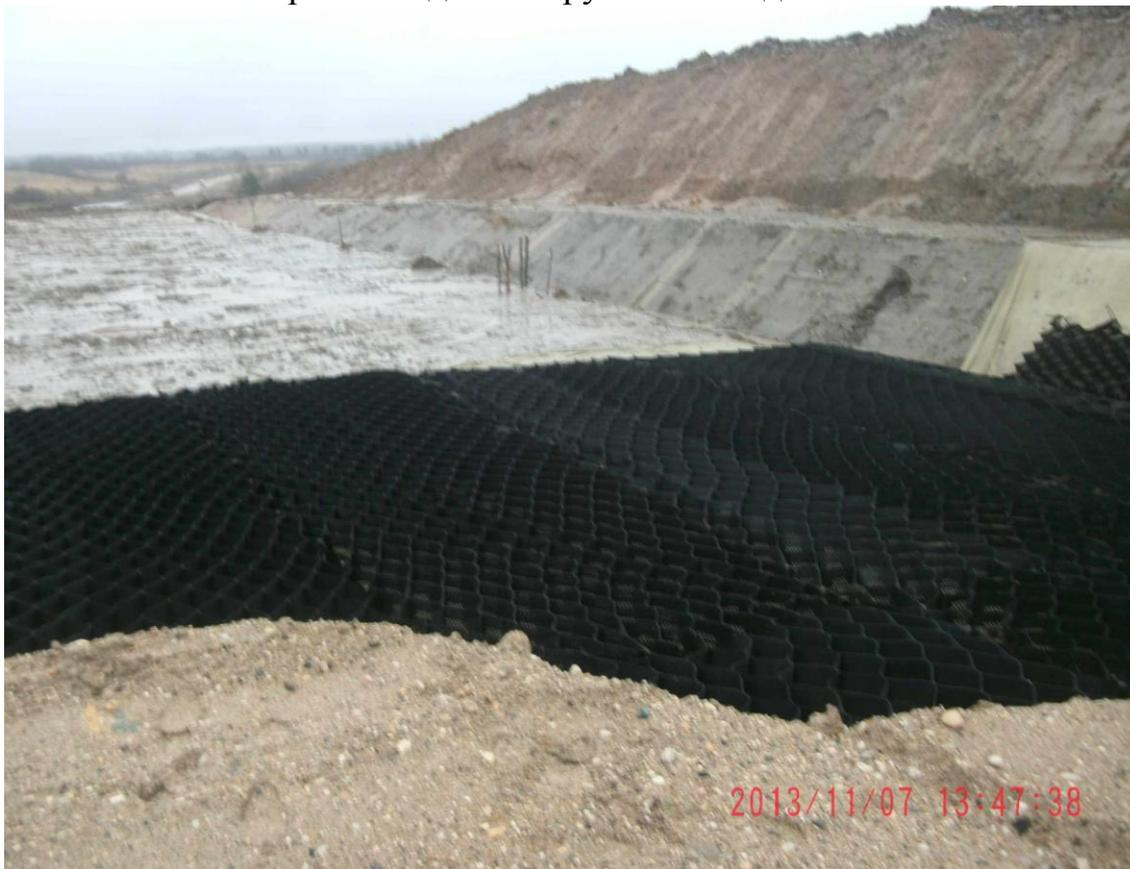
Более широкое применение находит технология армирования конструктивных слоев дорожных одежд геосетками. Возросшие транспортные потоки, увеличение нагрузок на дорожное полотно приводят к многочисленным выбоинам, трещинам, просадкам и колеям на покрытиях автомобильных дорог. Применение геосеток позволит продлить межремонтные сроки службы дорожных одежд, растянуть во времени процесс образования отраженных трещин, сгладит последствия наличия в земляном полотне неоднородных
