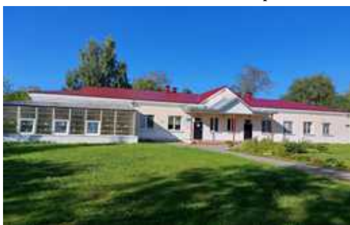
Рис. 11 Выполнен капитальный ремонт кровли здания БУ СО ВО «Шекснинский центр помощи детям, оставшимся без попечения родителей «Альтаир»
