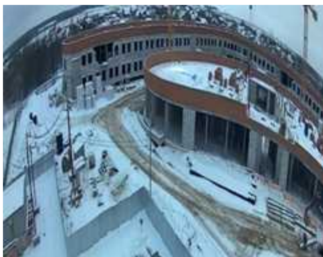
Рис. 9 Ход строительства Дома социального обслуживания для престарелых и инвалидов в с. Молочное на 200 мест
