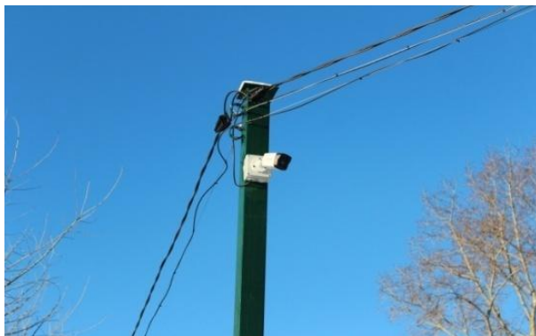
Рис. 14. Выполнение работ по созданию системы наружного периметрального видеонаблюдения АУ СО ВО «Дом социального обслуживания «Сосновая роща»
