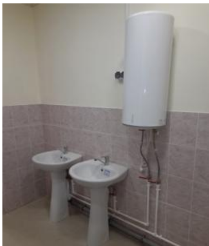
Рис. 34. Ремонт жилого корпуса в загородном оздоровительном лагере «Единство»
