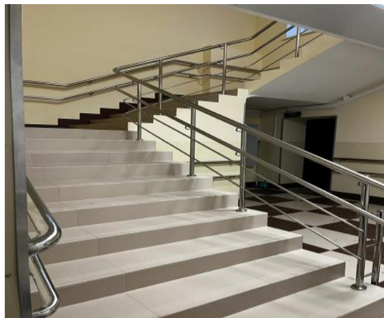
Рис. 9. Капитальный ремонт помещений АУ СО ВО «Вологодский дом социального обслуживания»
