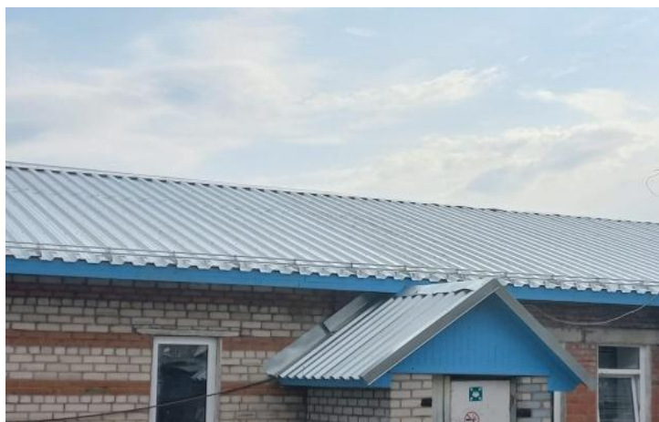
Рис. 12. Капитальный ремонт кровли БУ СО ВО «Кадниковский центр помощи детям, оставшимся без попечения родителей»
