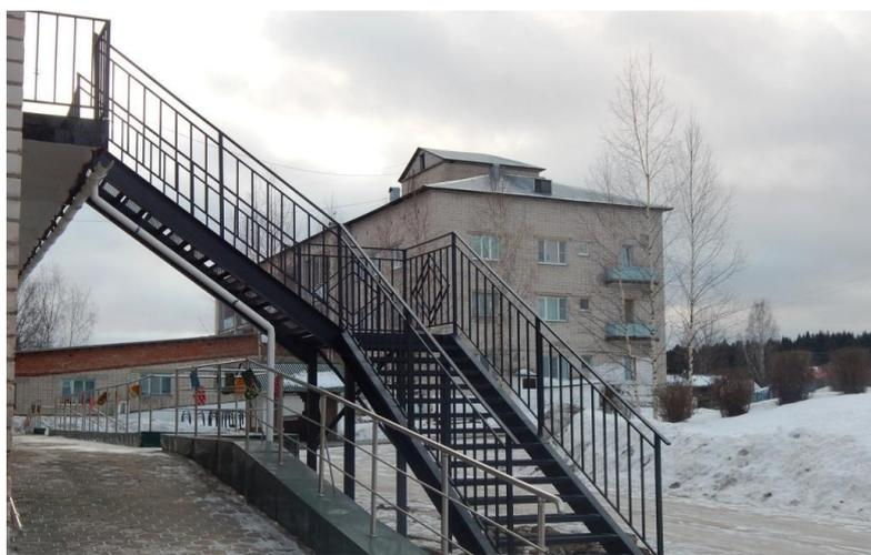
Рис. 7. Капитальный ремонт путей эвакуации спального корпуса АУ СО ВО «Красавинский психоневрологический интернат»
