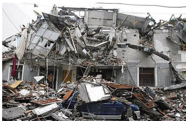
Рисунок 2 - Последствия землетрясения в Китае, 2010 г
